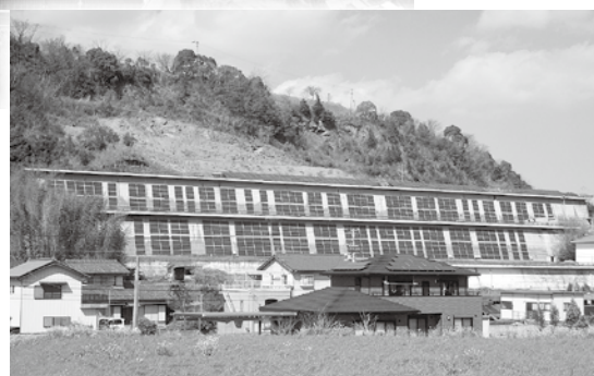
向麻山地すべり箇所
