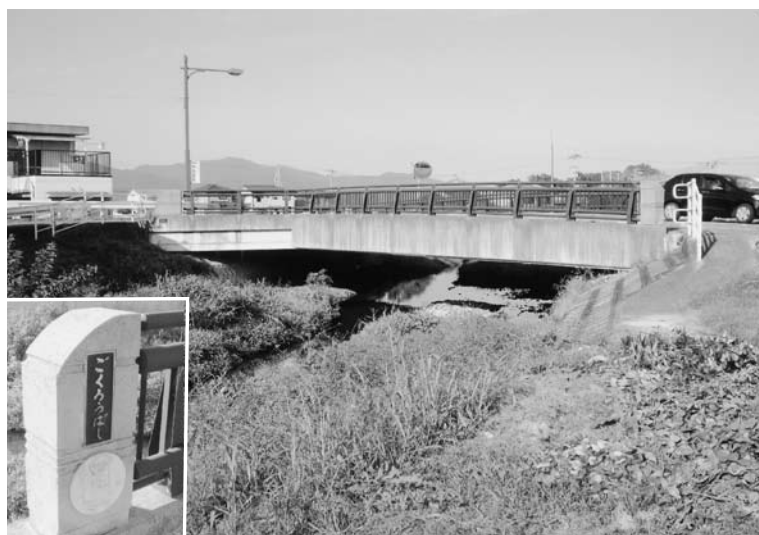
耐震補強が完了している橋
