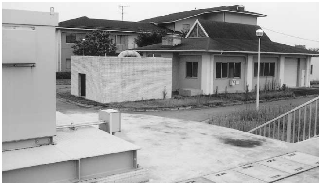
公共下水道鴨島終末処理場
