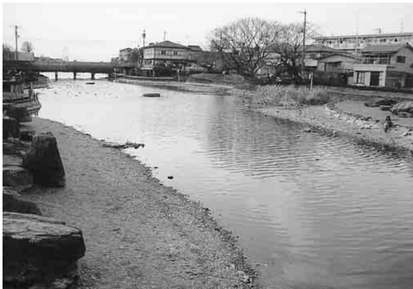
防災監視カメラ設置予定の江川
