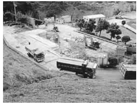
解体中の山川環境センター
