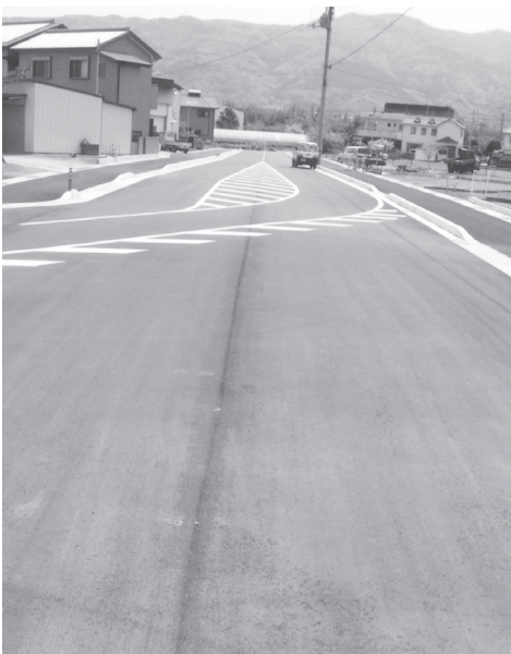
工事中の本郷・春日免線
