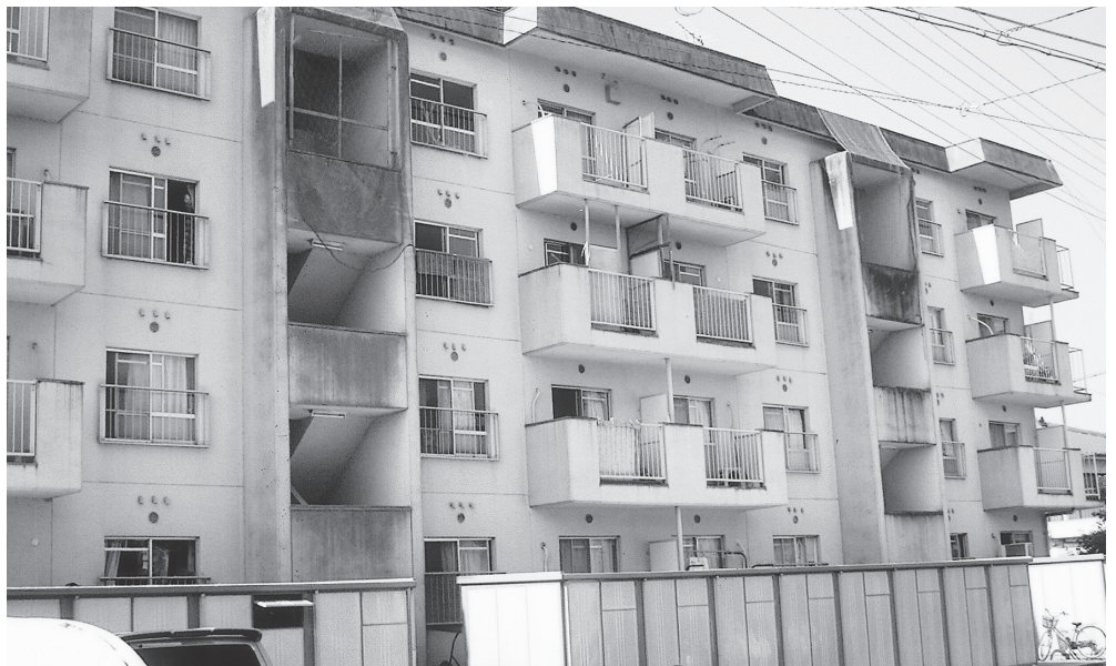
修繕の待たれる市営住宅
