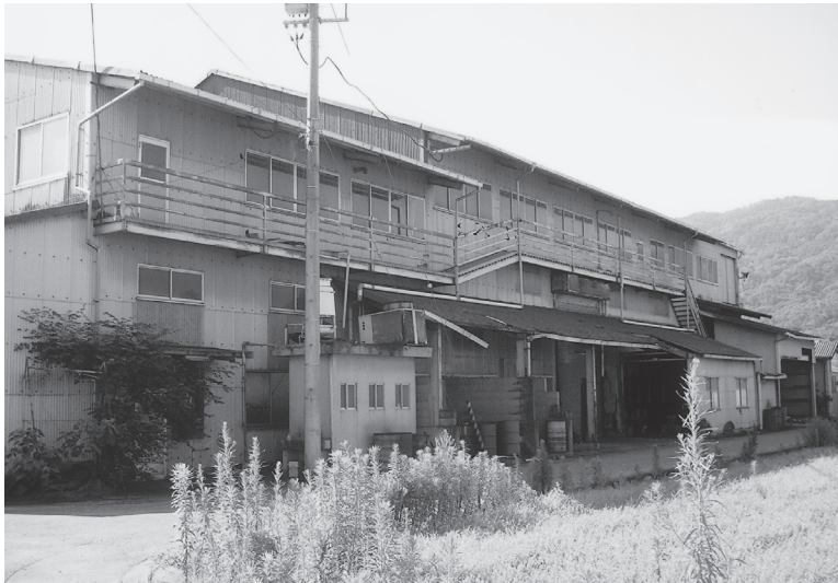
他市へ移転した工場建屋
