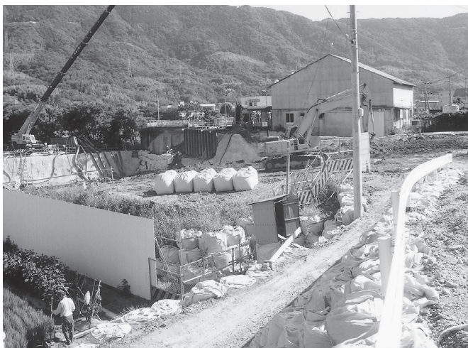
建設中の排水機場 一 川島町桑村
