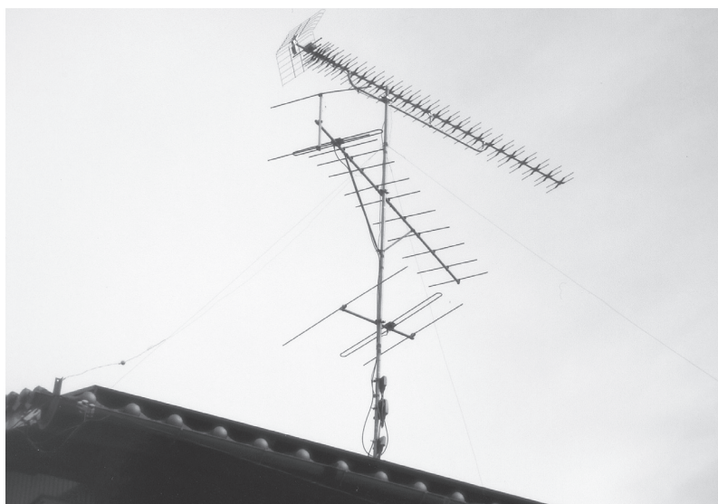
デジタル用アンテナ(上の部分)
