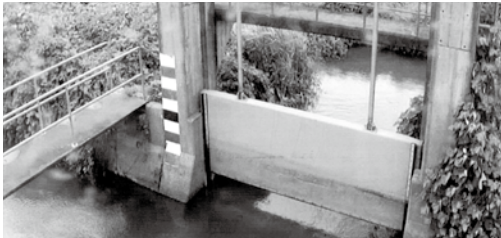
改修された飯尾樋門
