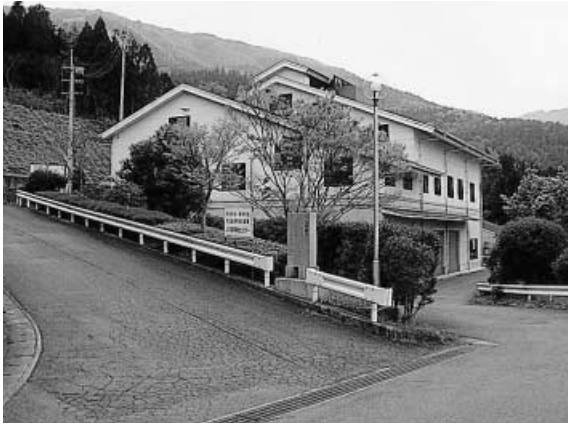
山川環境センター
