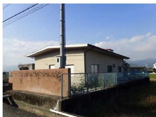
図 2-4 山川町浄水場
