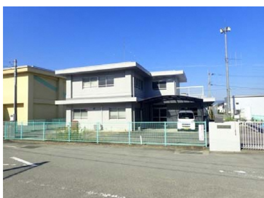
図 2-3 川島町浄水場
