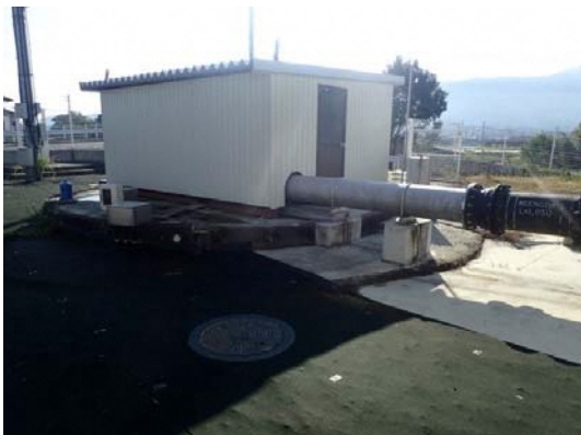
図 2-1 鴨島町取水井
