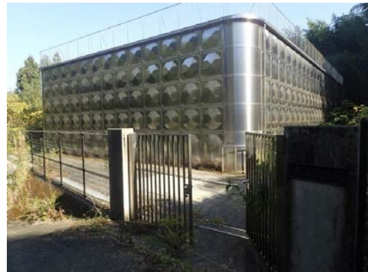
図 2-6 川島低区配水池②
