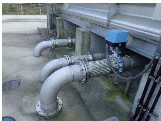
図 3-2 川島第 3 高区配水池 緊急遮断弁
