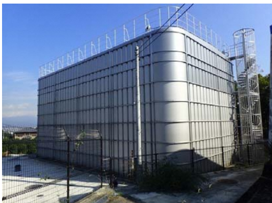
図 2-5 高ノ原配水池②
