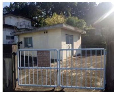
図 2-8 川島第2 高区受水場
