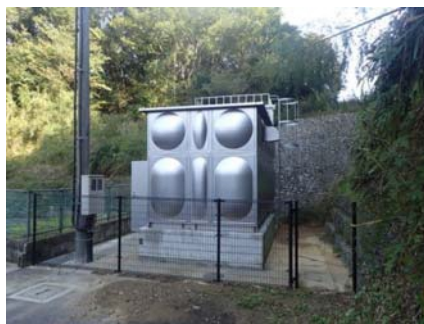
図 2-7 ハイランドポンプ場
