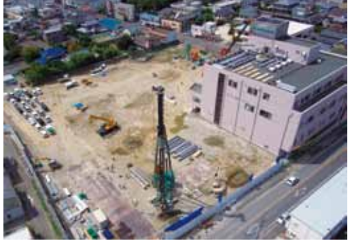
8月下旬の建設現場
