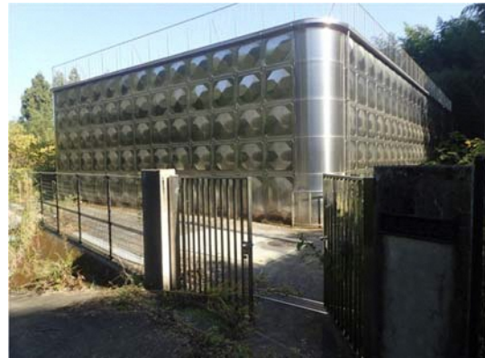
図 2-6 川島低区配水池②
