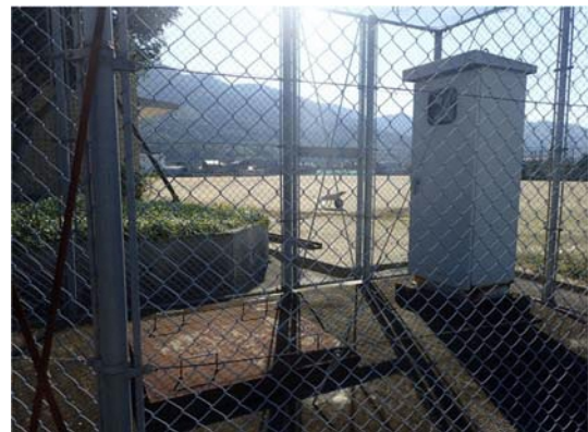
図 2-2 川島町取水井(3号井)
