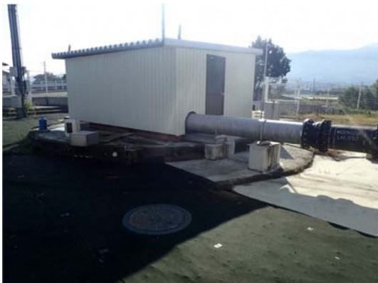
図 2-1 鴨島町取水井
