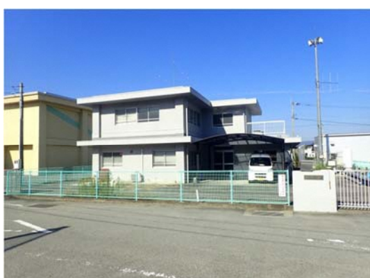
図 2-3 川島町浄水場
