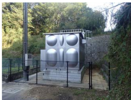
図 2-7 ハイランドポンプ場
