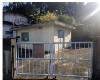
図 2-8 川島第2 高区受水場
