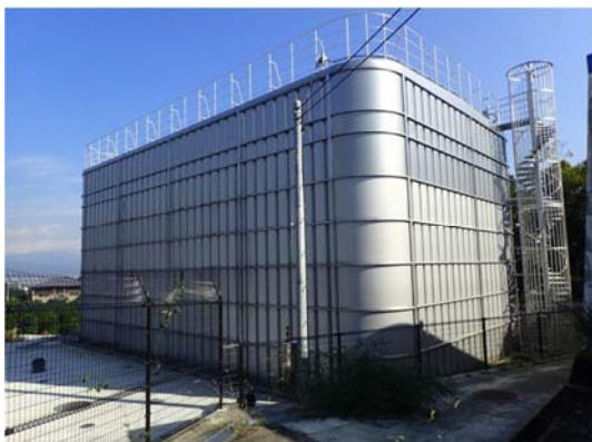
図 2-5 高ノ原配水池②
