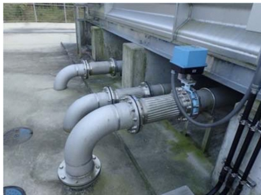
図 3-2 川島第 3 高区配水池 緊急遮断弁
