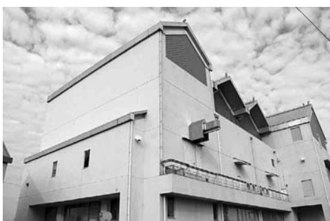
大規模改修工事を行う鴨島公民館
