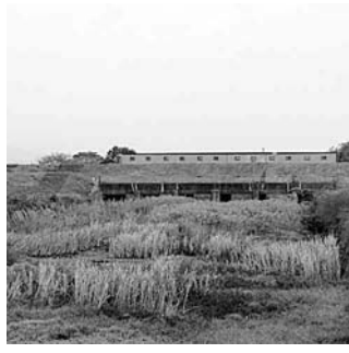
排水機場が建設予定のほたる川
