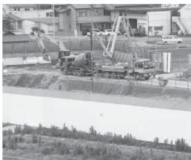
消防庁舎建設現場
