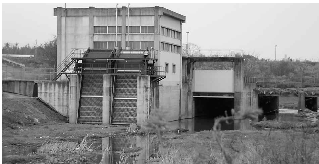
岩屋谷川排水機場
