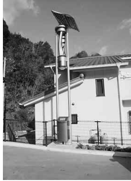
美郷物産館駐車場に設置した防犯灯
