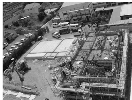
着々と工事が進む県立川島中学校
