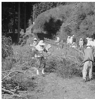
修復作業を行う様子
