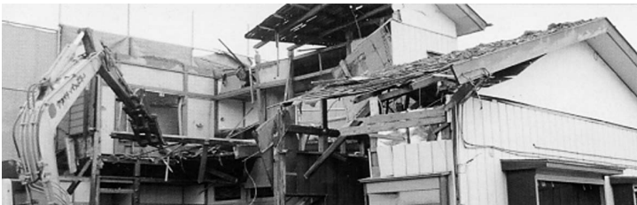
③外装材・上部構造部分の取り壊し
