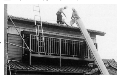
②屋根ふき材を取り外し
