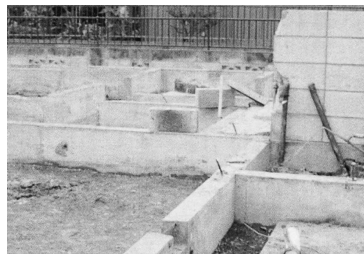
④基礎および基礎杭の取り壊し
