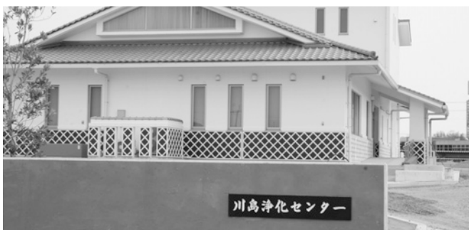
川島浄化センター
