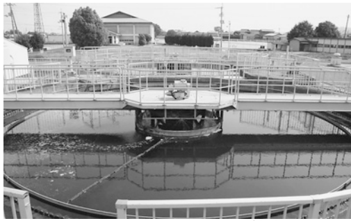
鴨島中央浄化センターの最終沈澱池
