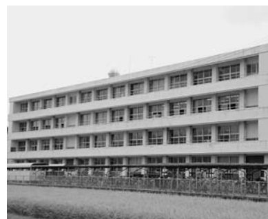
耐震改修工事を予定している鴨島東中学校
