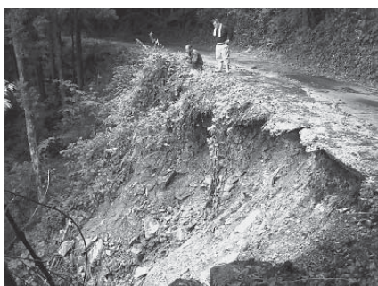
市道竹屋敷小竹線が損壊
