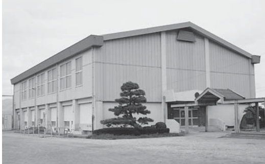
耐震改修工事を行う上浦小学校屋内運動場(写真上)と牛島小学校屋内運動場(写真下)
