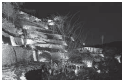
冬の夜空に幻想的な光景が浮かぶ石積み
