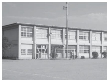
耐震改修工事が完了した山瀬小学校
