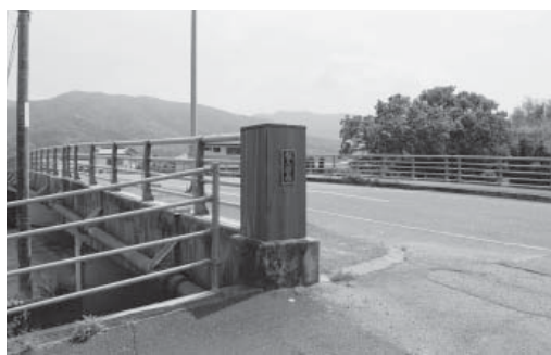
耐震化・長寿命化を施される飯尾新橋
