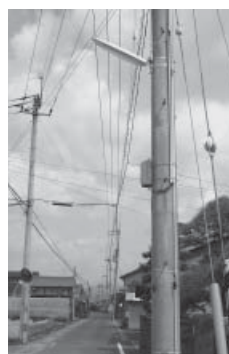
鴨島第一中学校通学路に設置されたLED防犯灯
