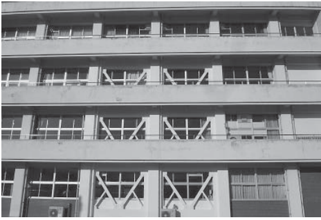
耐震改修工事が終わった鴨島東中学校
