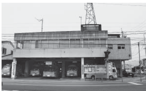
早期整備が求められている、徳島中央広域連合消防庁舎
