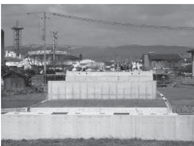
建設中の本郷春日免線は、平成24年4月の供用開始をめざしています
