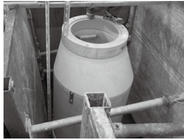
共用開始区域拡大に向け工事が進む下水道
