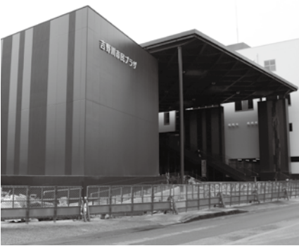
開館に向け工事が進む市民プラザ
