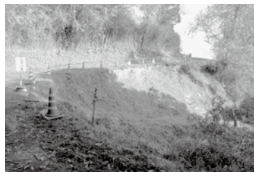
▲川田八幡・天王原線 市道災害復旧工事
