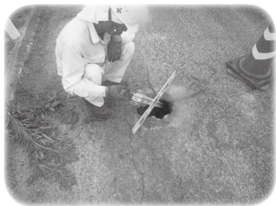
陥没穴補修工事
