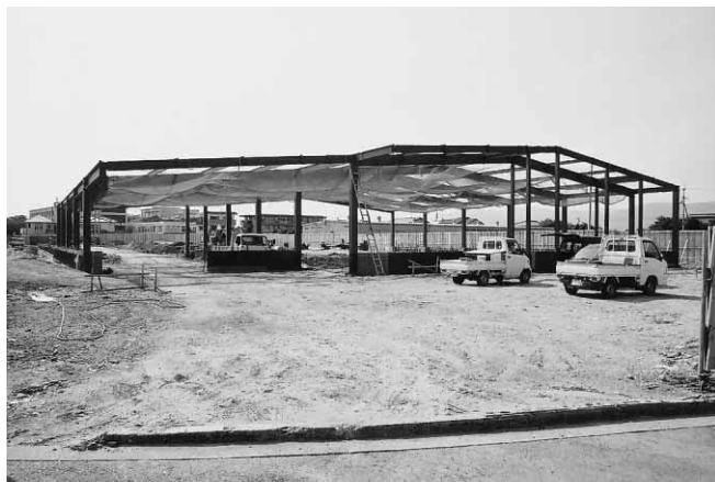
食鳥工場建設地
