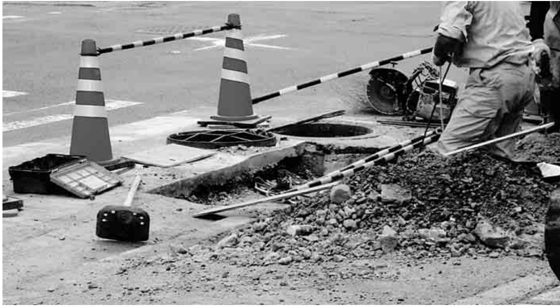
中央雨水幹線への接続工事現場
