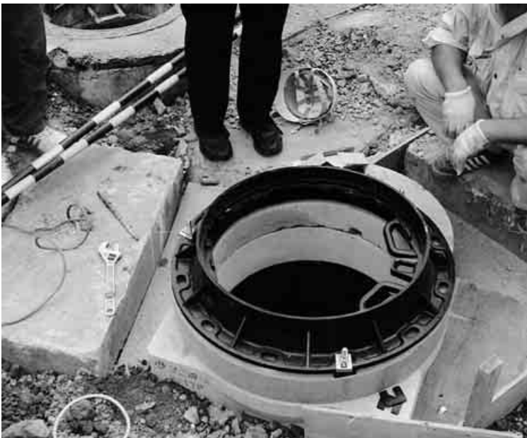
中央雨水幹線への接続工事現場
