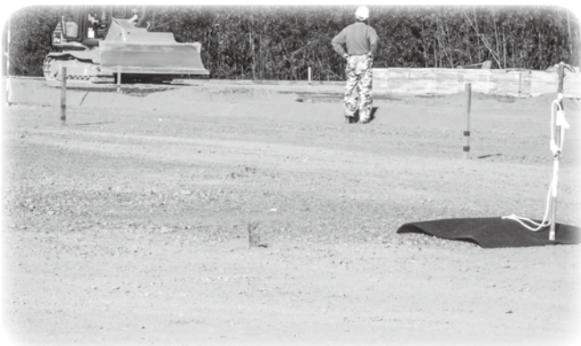
鴨島閉鎖処分場公園整備工事
