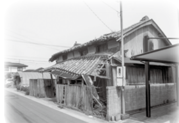
老朽危険空き家
