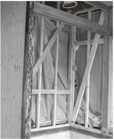
耐震改修工事
