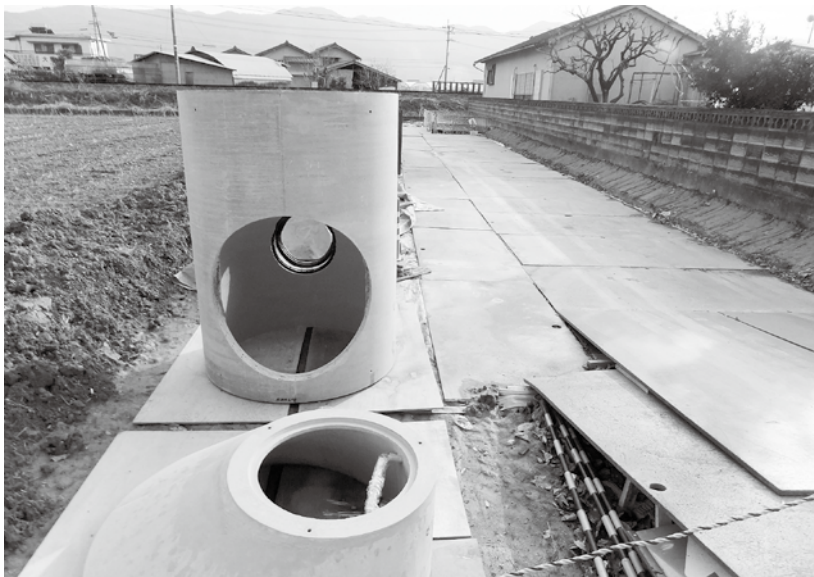
雨水対策工事現場
