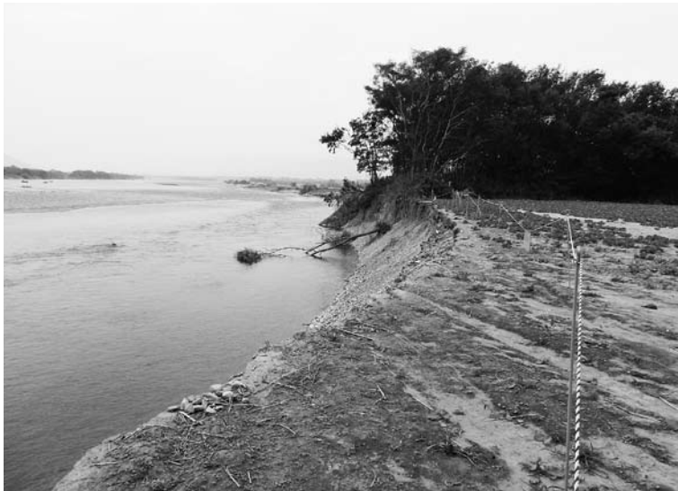
減災工事前の善入寺島
