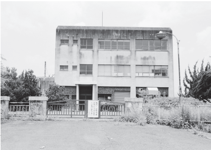
市役所東側の鴨島浄水場
