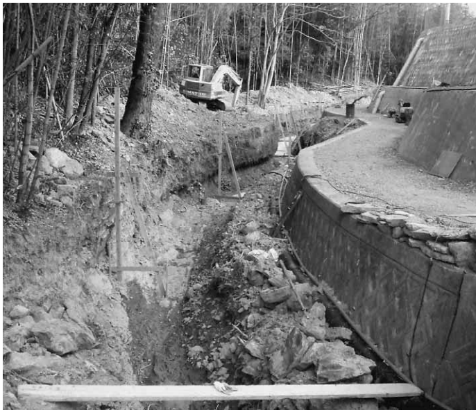
工事中の湯吸谷川
