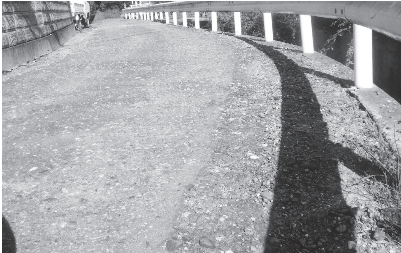
補修を必要とする市道
