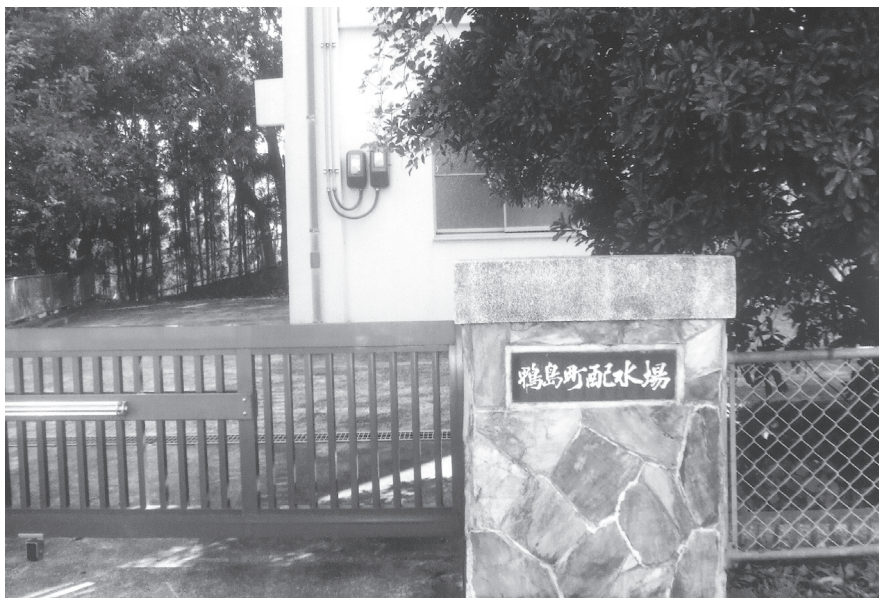
耐震バルブを設置した鴨島町配水場
