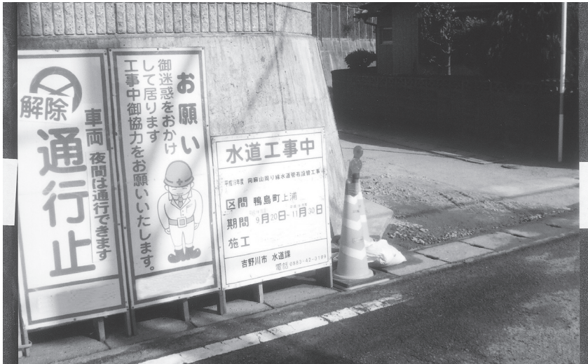
水道工事現場
