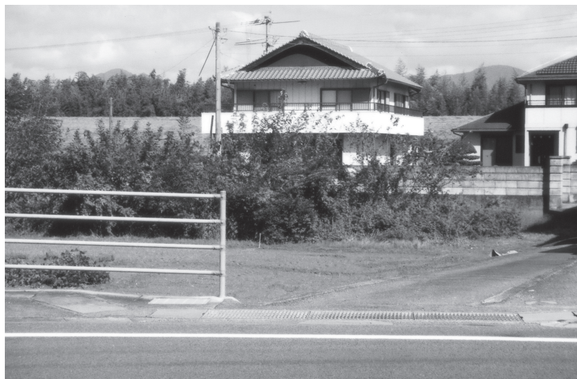
雨水排水工事が待たれる川島地区
