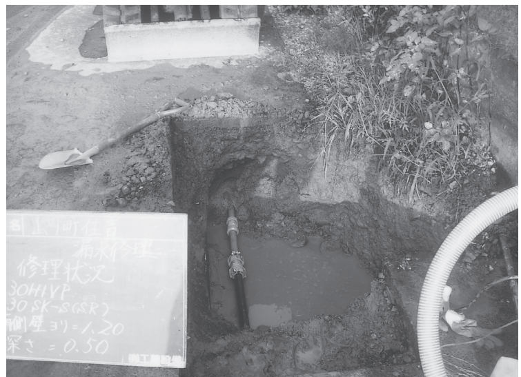
漏水修理前（山川町住吉）
