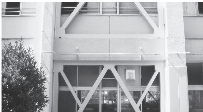
耐震工事が行われた校舎
