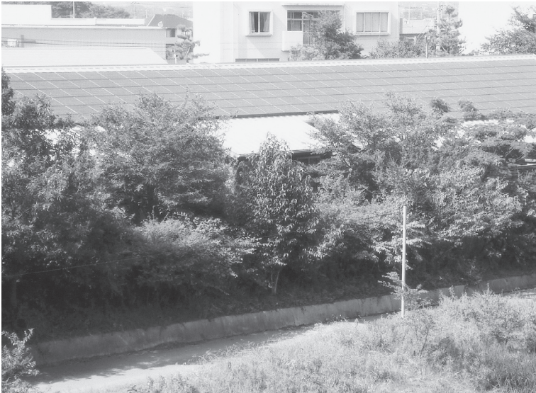
太陽光発電パネルを設置した建物
