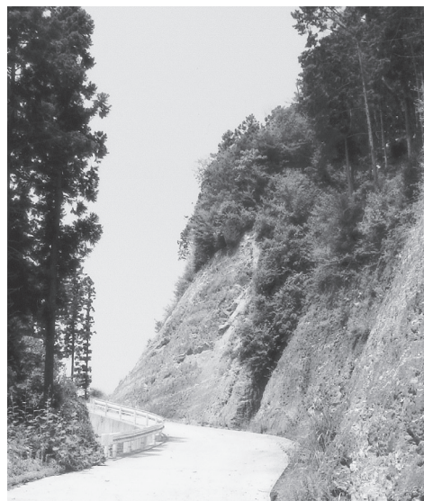
林道倉羅樫平線開設工事
